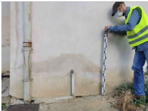
fiche de repère de crue
