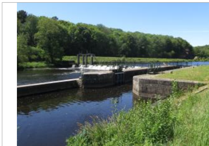
Echelle aval de l'écluse de Kerbescher
