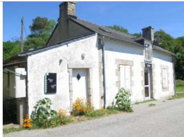
Maison éclusière de Kerbescher à Plumélieu-Bieuzy
