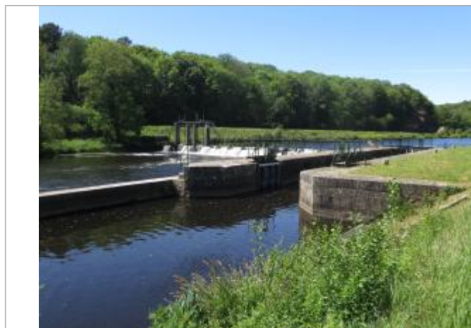
Echelle aval de l'écluse de Kerbescher
