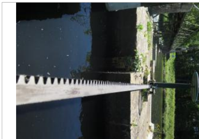
Echelle amont de l'écluse de Kerbescher
