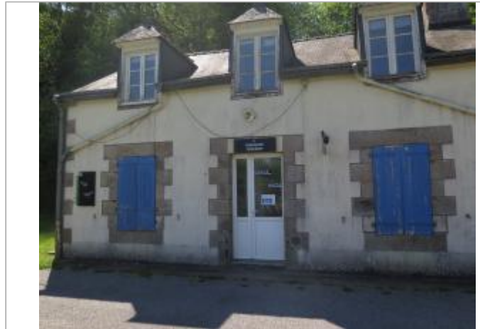
Maison éclusière de Rimaison à Plumélieu-Bieuzy
