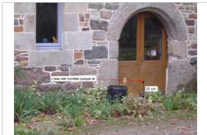
Repère à la porte d'entrée du moulin lors du relevé
