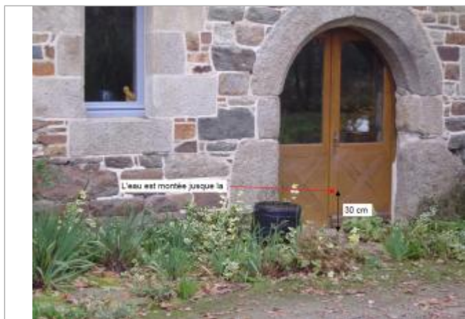
Repère à la porte d'entrée du moulin lors du relevé
