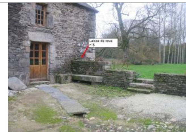
Muret sur le coté du bâtiment lors du relevé
