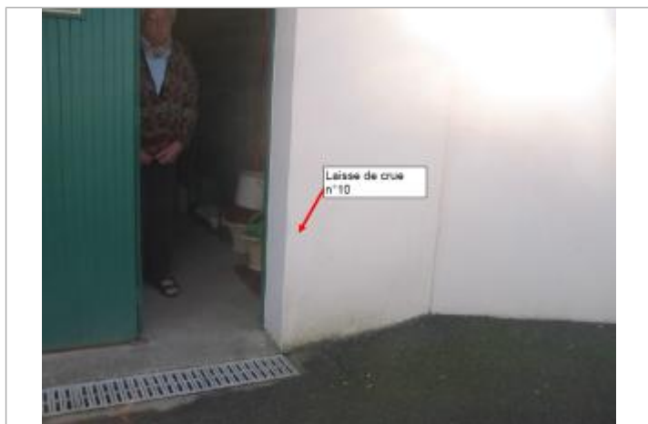
Garage lors du relevé des laisses de crues en 2003
