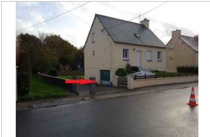
Maison et garage en 2023
