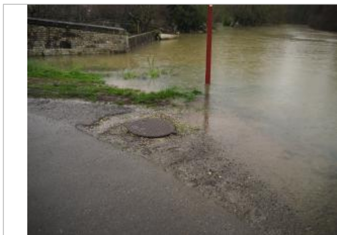
Niveau eau au pic
