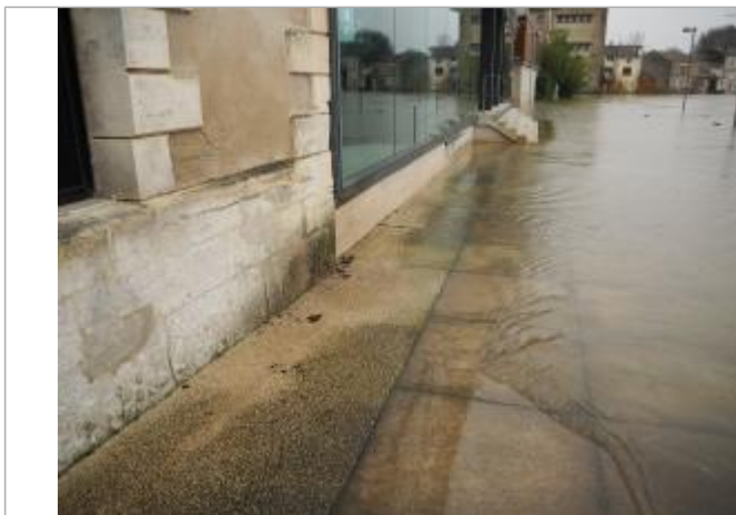
Niveau eau au pic
