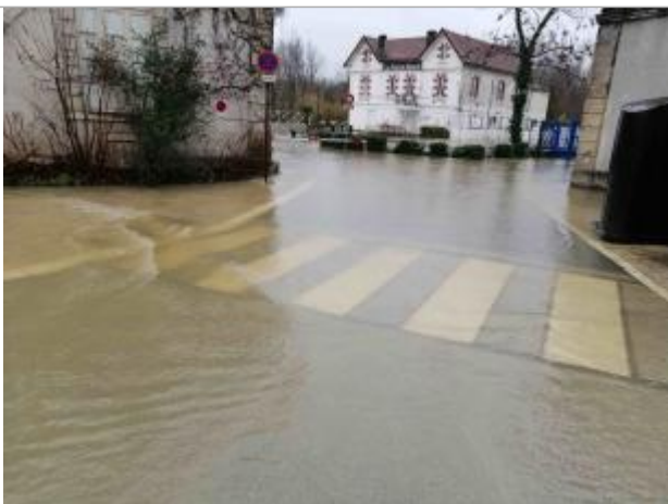
Niveau eau au pic
