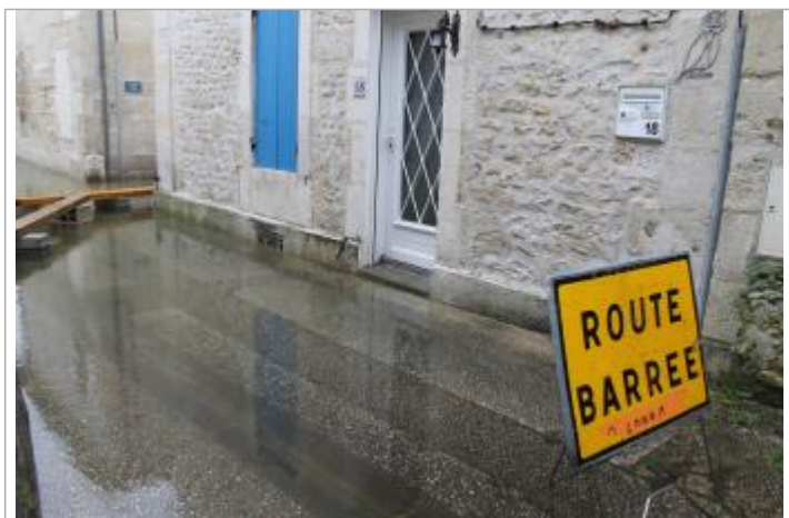
Niveau eau au pic
