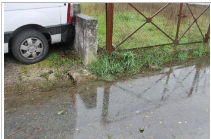
Niveau eau au pic
