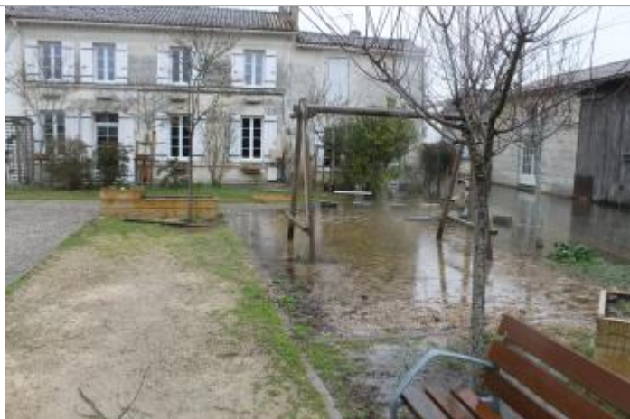
Niveau eau au pic
