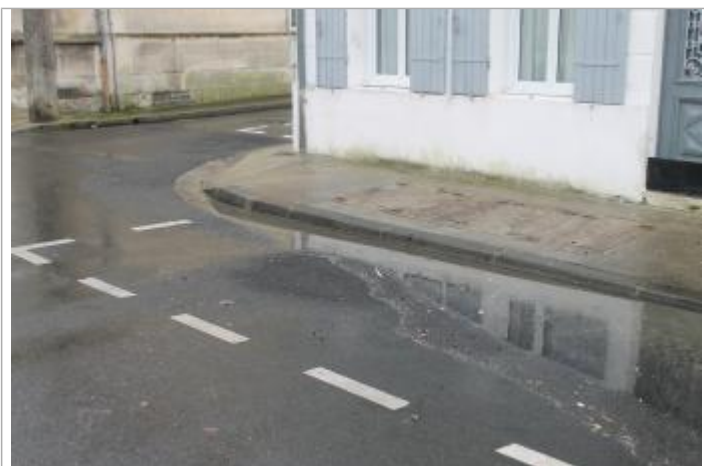
Niveau eau au pic
