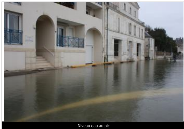
Niveau eau au pic
