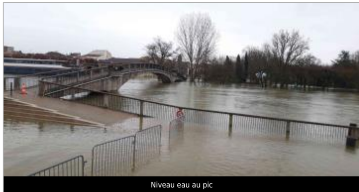
Niveau eau au pic
