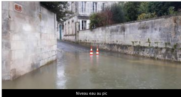
Niveau eau au pic
