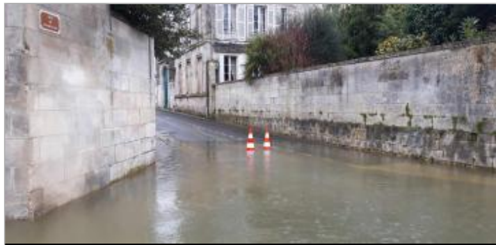
Niveau eau au pic
