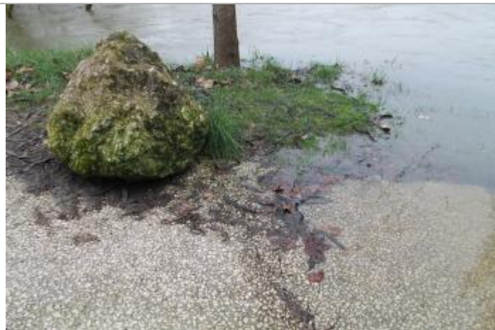
Niveau eau au pic
