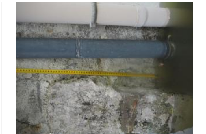
Niveau eau au pic
