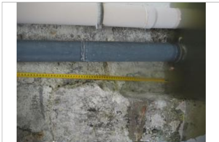
Niveau eau au pic
