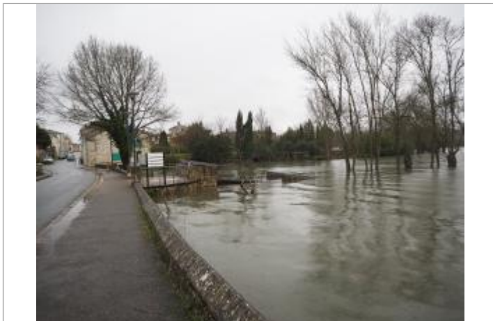
Niveau eau au pic
