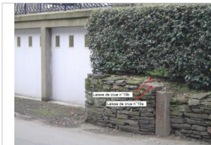
Muret près des garages
