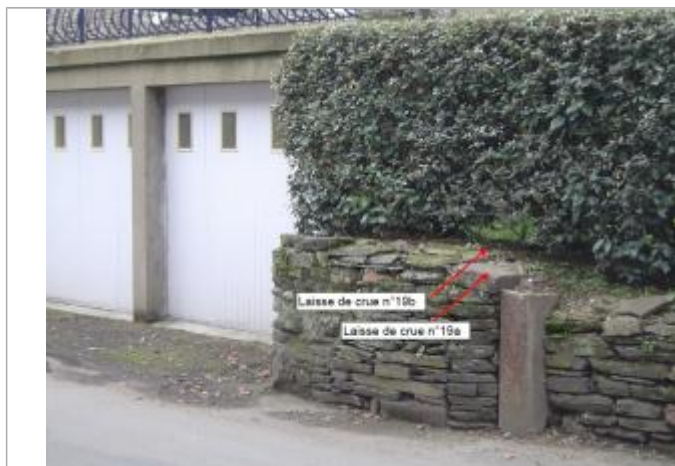
Muret près des garages
