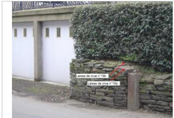
muret à coté des garages rue de la gare
