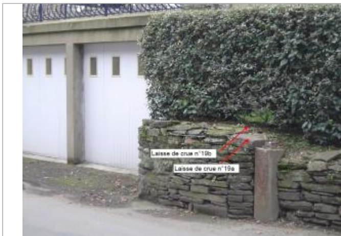
muret à coté des garages rue de la gare
