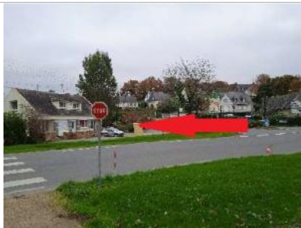
Maison au carrefour de la route nationale (RD5) et de la rue de Pen Ar Pont
