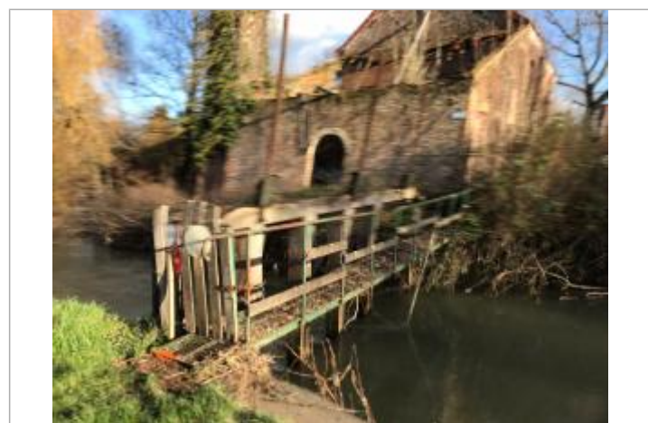
nivellement à la marque orange bord passerelle
