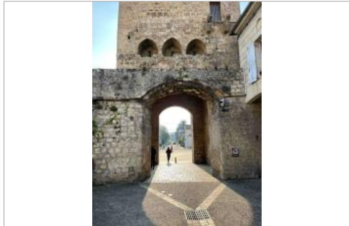
Vue du site depuis l'intérieur de la ville
