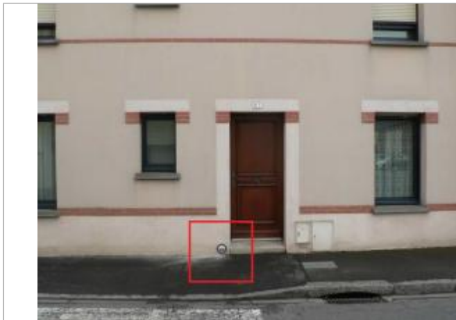
Maison au 1bis, rue de Coulon et repère
