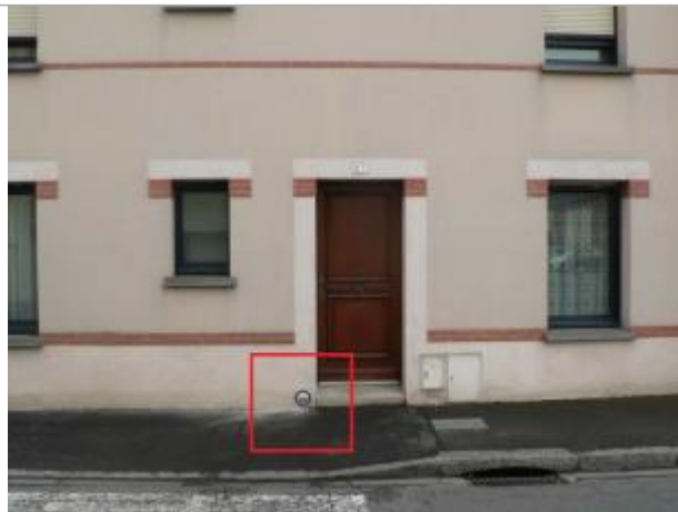
Maison au 1bis, rue de Coulon et repère
