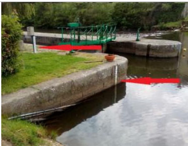
Echelle limnimétrique de la station Vigicrues amont écluse
