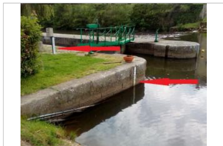
Echelle limnimétrique de la station Vigicrues amont écluse
