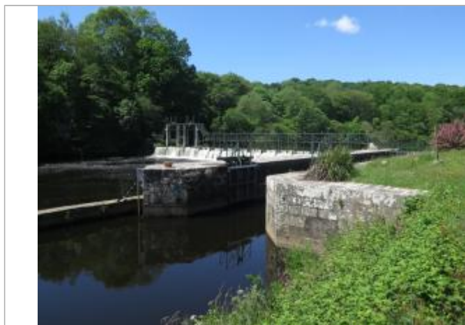
aval écluse de Divit (échelle disparue)
