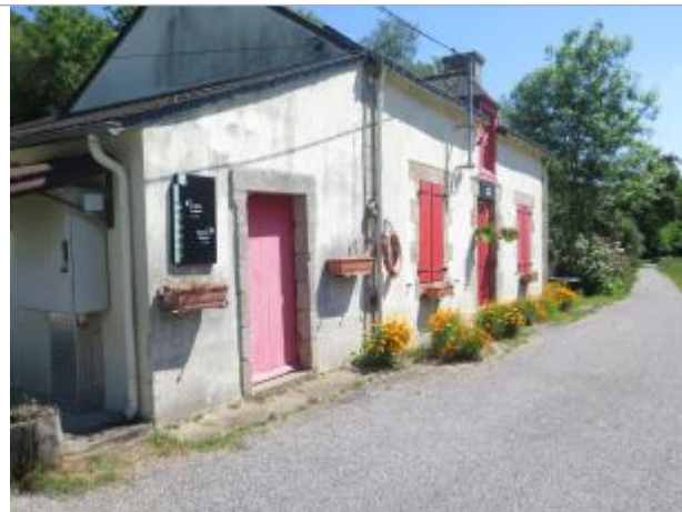
Maison éclusière n°5 de Divit
