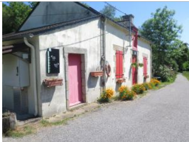
Maison éclusière n°5 de Divit
