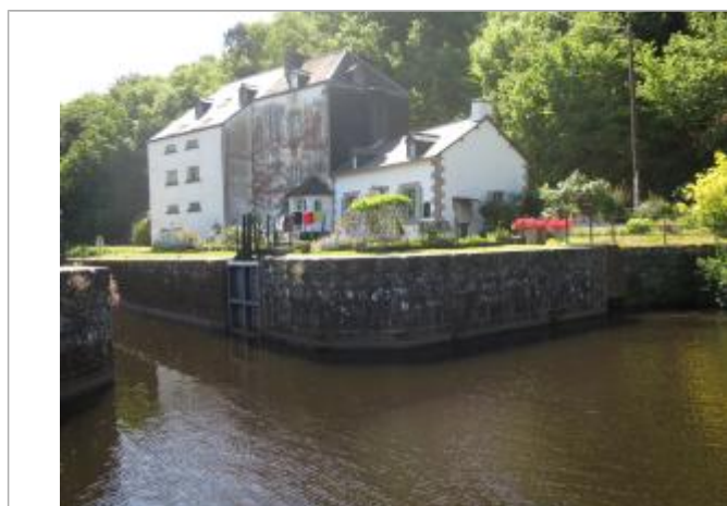
aval écluse du Roch (échelle disparue)
