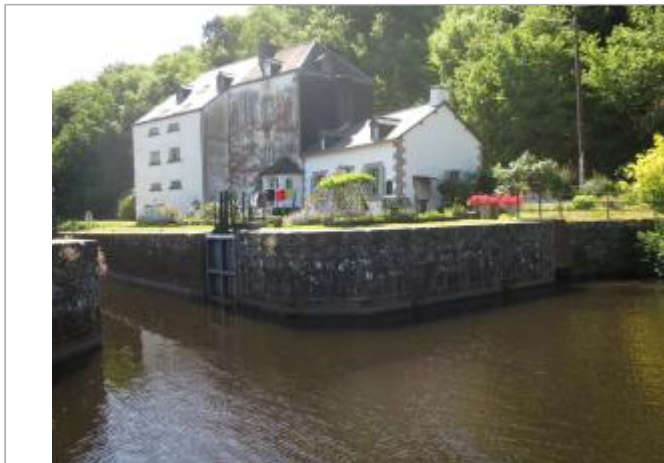
aval écluse du Roch à Saint-Thuriau (échelle disparue)
