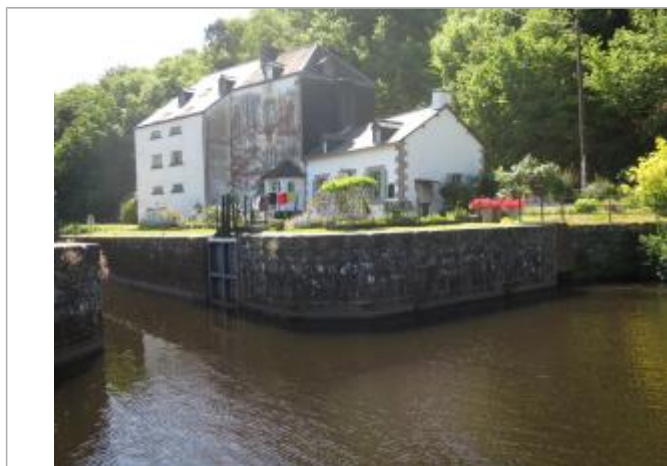
aval écluse du Roch (échelle disparue)
