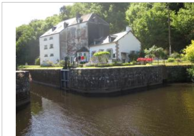
aval écluse du Roch (échelle disparue)
