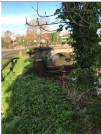
Nivellement à la marque orange sur structure métallique
