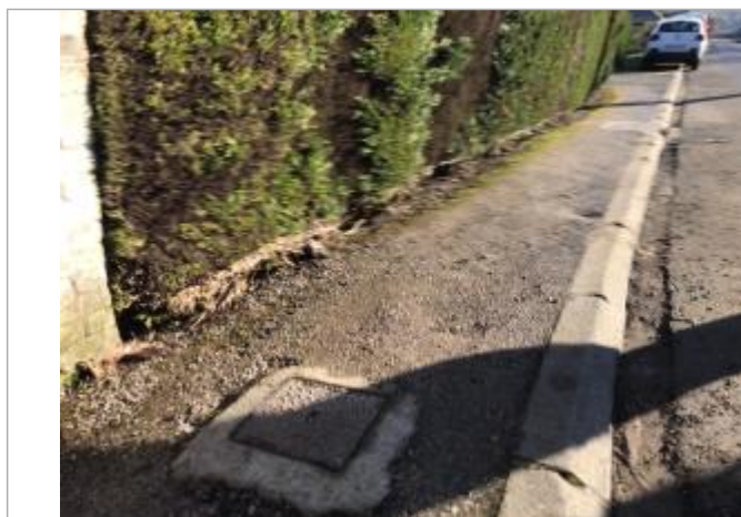
LC tout le long de la haie
