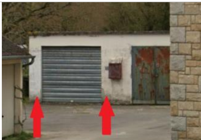
Ancien hangar des services techniques
