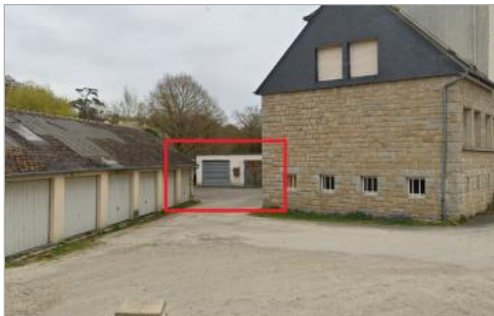
Ancien hangar des services techniques
