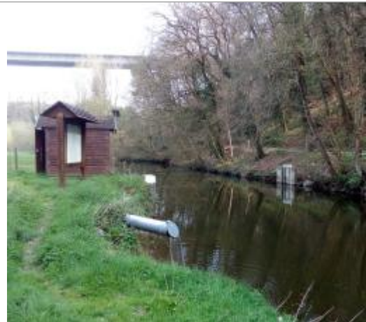
site de la station hydrométrique de l'Arguenon entrée de retenue
