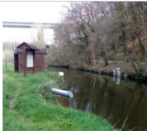
site de la station hydrométrique de l'Arguenon entrée de retenue
