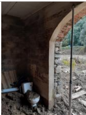
Vue du repère, photo OTEIS
