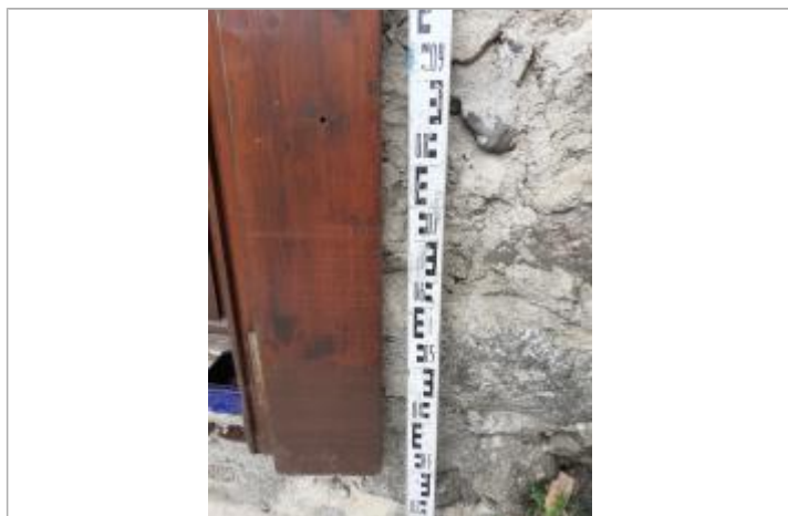
Vue du repère, photo OTEIS
