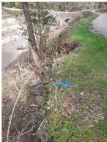
Vue du repère, photo OTEIS
