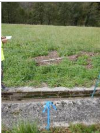
Vue du repère, photo OTEIS
