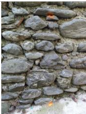
Vue du repère, photo OTEIS
