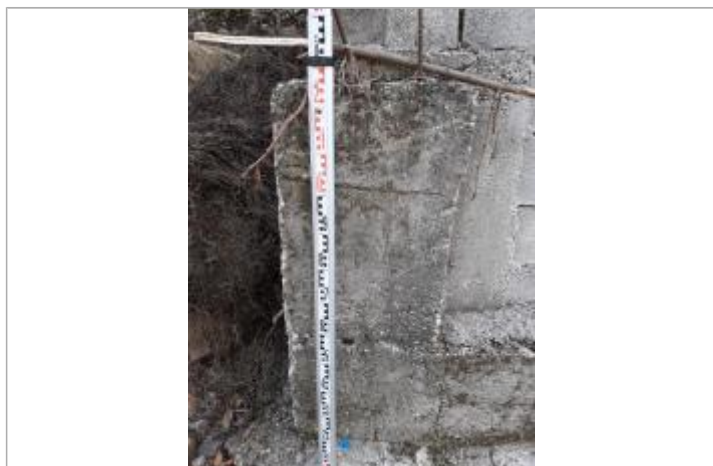
Vue du repère, photo OTEIS
