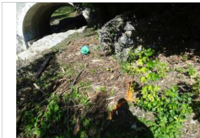
Vue du repère, photo OTEIS
