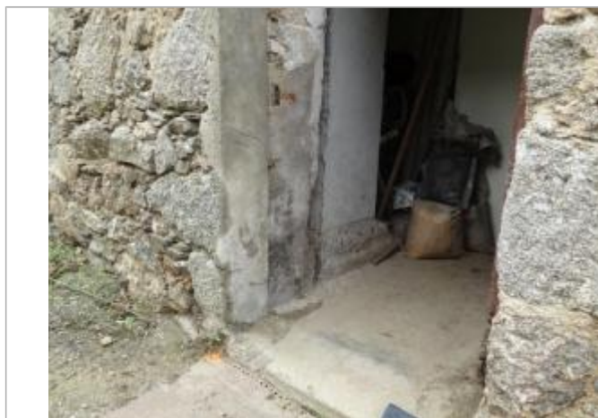
Vue du repère, photo OTEIS
